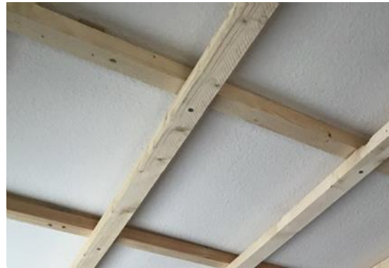
kreuzlagige Lattung (direkte Befestigung) Niveaueausgleich über Stell-schrauben möglich
