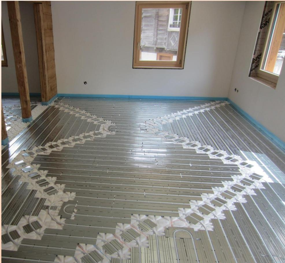
**Das Fussbodenheizungssystem für Trockenbau**
